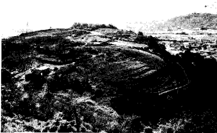
宅地の造成で 自然の緑が、 次々と壊され ていく
