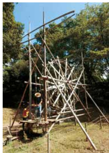
上総掘り櫓 （上総掘り技術伝承研究会 HP より）
